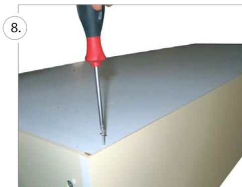
8. Avvitare le viti in tutti i fori della schiena facendola così aderire alla struttura.
